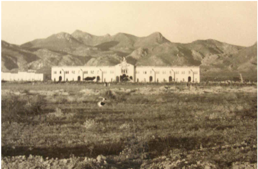
Imagen 5. El estadio de la Ciudad Deportiva al término de la obra.
